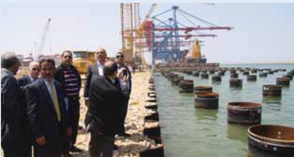
بعض المشاركين في الزيارة لمواقع أعمال التوسيع وظهرت في الصورة محطة الحاويات
